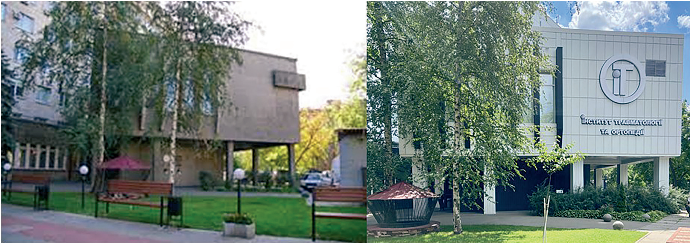
Рис. 4. Фото фасаду ІТО до та після реконструкції.
