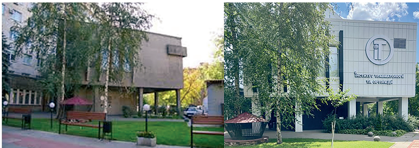
Рис. 4. Фото фасаду ІТО до та після реконструкції.
